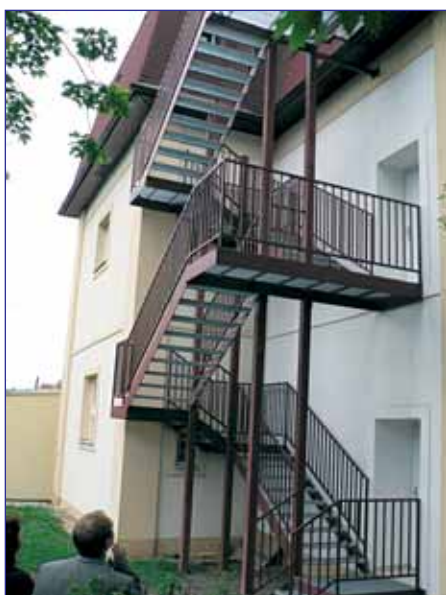
V budově v ulici Edisonova proběhla během prázdnin stavba venkovního požárního schodiště se třemi novými vstupními dveřmi do jednotlivých podlaží budovy.
