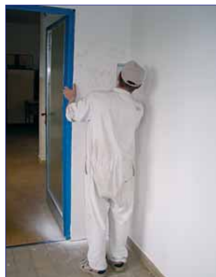
V budově v Dopplerově ulici byly všechny třídy a chodby vymalovány. Opraveny byly poničené nebo proražené příčky a stěny.
