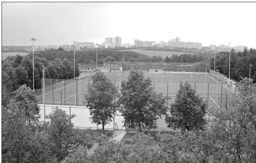
Celkový pohled na rekreačně sportovní areál těsně po dokončení
