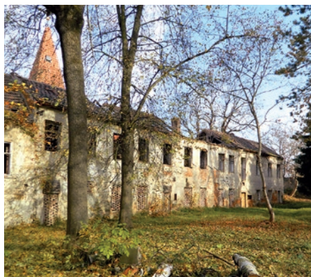
Vstupy jsou zazděné.
