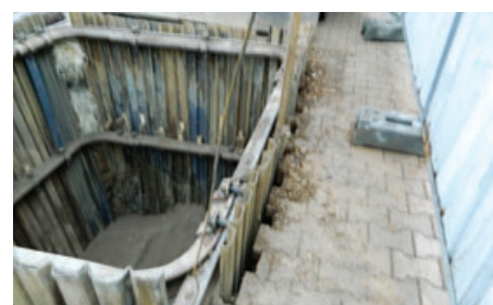
Úprava kanalizace ve Wattově ulici.
