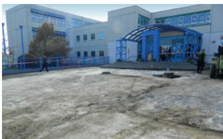
Příprava nového asfaltového povrchu.
